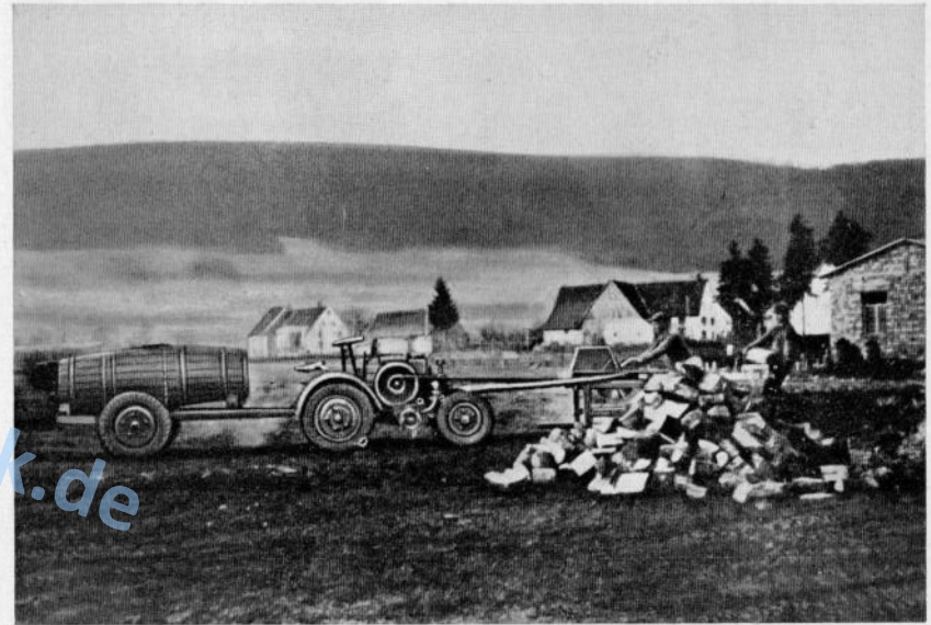
Der Kramer als Antriebsmaschine beim Holzsägen Mit dem Kramer vielseitige flotte Arbeit bei verminderten Unkosten
